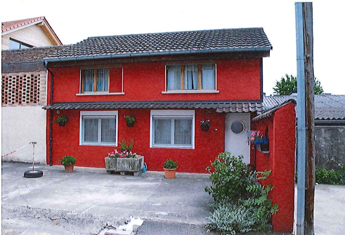
Vue de la façade Nord-Ouest
