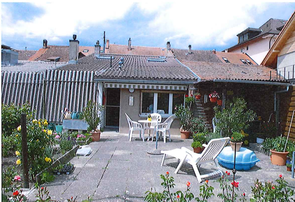
Vue de la façade Sud-Est avec le hangar à gauche et le voisin à droite
