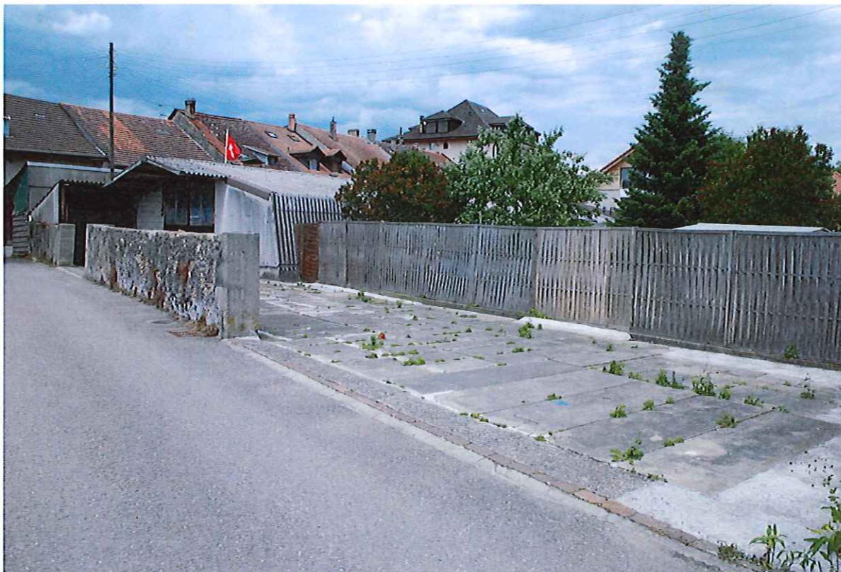
Vue de la halle, atelier
