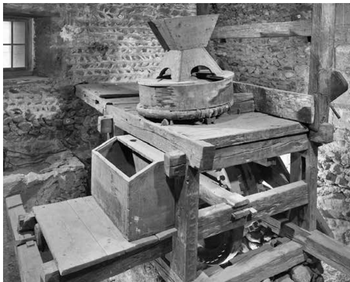
Le moulin de Valère, rare exemple de mécanisme fonctionnant à la force des bras.
